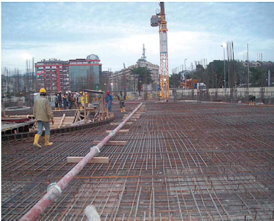
Slika 1.: Priprema za betoniranje ab ploče, cjevodvod stacionarne pumpe
